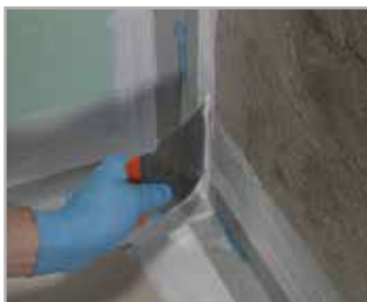
Uszczelnianie narożników z użyciem winylowej taśmy MAPEBAND PE120 i gotowych narożników
