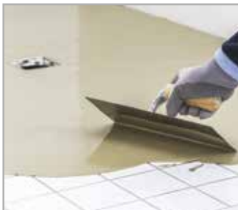
Wyglądanie podłogi wodoodporną masą PLANEX HR / HR MAXI
