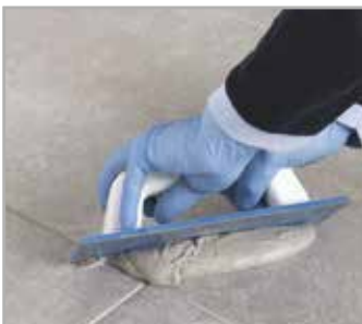
Wypełnianie szczelin z użyciem FLEXCOLOR 4 LVT
