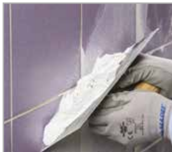
Wyglądanie podłogi i ściany ceramiczną zaprawą PLANIPREP 4 LVT
