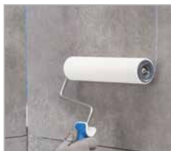
Nakładanie lakieru ochronnego MAPECOAT 4 LVT
