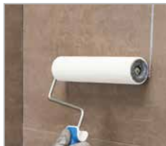
Nakładanie lakieru ochronnego MAPECOAT 4 LVT
