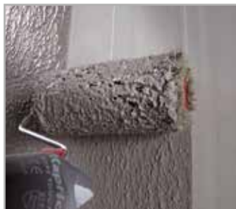
Nakładanie wałkiem pierwszej warstwy MAPELASTIC SMART
