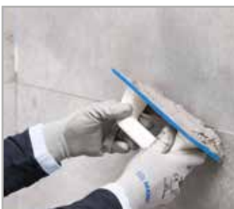
Wypełnianie szczelin z użyciem FLEXCOLOR 4 LVT
