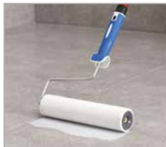
Nakładanie lakieru ochronnego MAPECOAT 4 LVT
