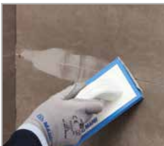
Wypełnianie szczelin z użyciem FLEXCOLOR 4 LVT
