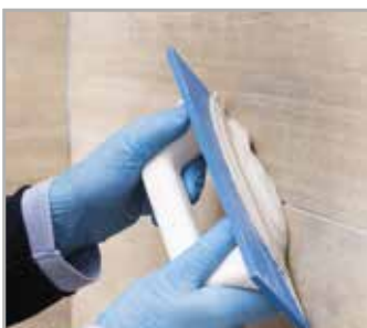
Wypełnianie szczelin z użyciem FLEXCOLOR 4 LVT
