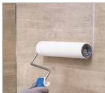
Nakładanie lakieru ochronnego MAPECOAT 4 LVT
