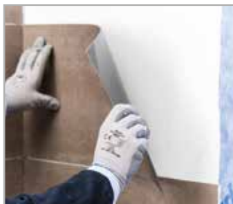
Przyklejanie LVT na klej ULTRABOND ECO MS 4 LVT WALL
