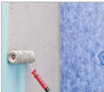
Nakładanie wałkiem kleju MAPEGUARD WP ADHESIVE
