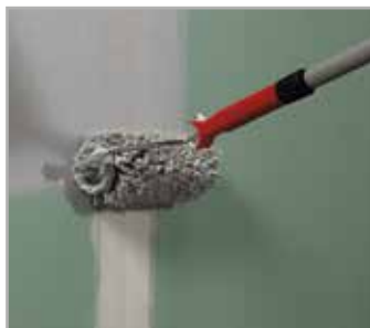
Nakładanie pierwszej warstwy hydroizolacji MAPEGUM WPS
